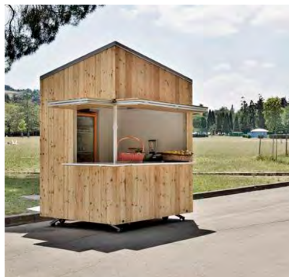
Chiosco mobile, posizionato su un rimorchio su ruote, con pannelli fotovoltaici in copertura, realizzato nel Parco dei Giardini Margherita, a Bologna, progetto di Giacomo Minelli.
