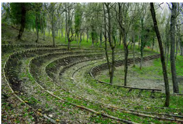
Il teatro nel bosco di Biccari, nel Parco Avventura dei Monti Dauni (FG), è nato a seguito di alcuni lavori per il contenimento di una frana. Nell'anfiteatro si realizzano attività didattiche per i bambini e prossimamente verrà installato un palcoscenico centrale per spettacoli teatrali.
